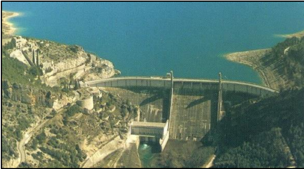
Figura 31. Presa de Buendía.
