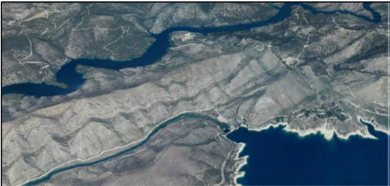
Figura 38. Montaje en perspectiva del entorno de la Presa de Buendía. La presa ha sido construida aprovechando una cluse en una antifforma. Se trata de un relieve conforme. Se aprecia también un valle colgado y cuevas (chevrons) en todos los flancos.
